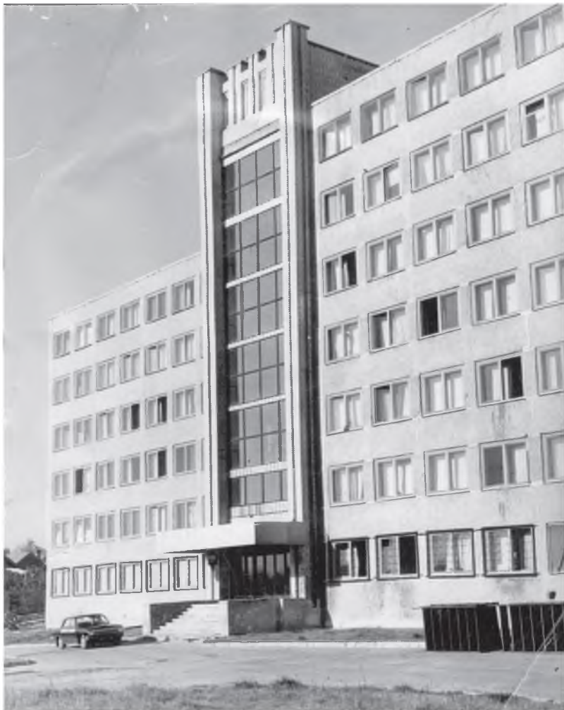
Производственное здание по адресу ул. Ванеева, д. 205.
