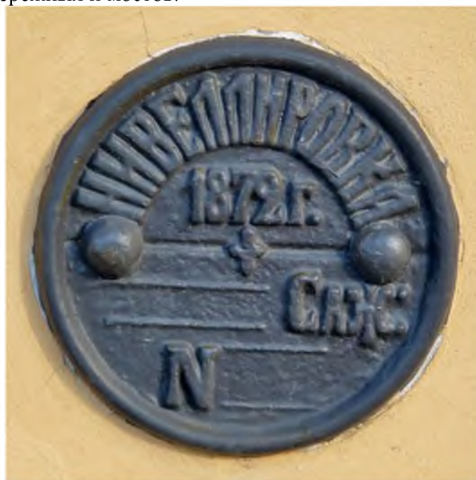
Рис. 5. Марка нивелировки 1872–1874 гг. конструкции М. А. Савицкого
