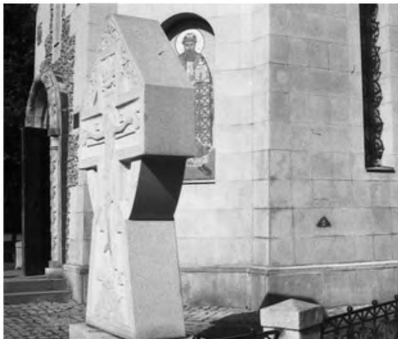
Рис. 12. Восстановленная нивелирная марка № 2210 на южной стене часовни святого благоверного князя Даниила Московского [13]
