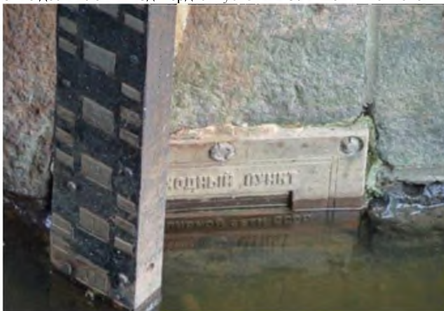
Рис. 2. Рейка футштока и пластина Тонберга (под предохранительной рамкой) исходного пункта нивелирования в России на Синем мосту в г. Кронштадте [4, 24]
