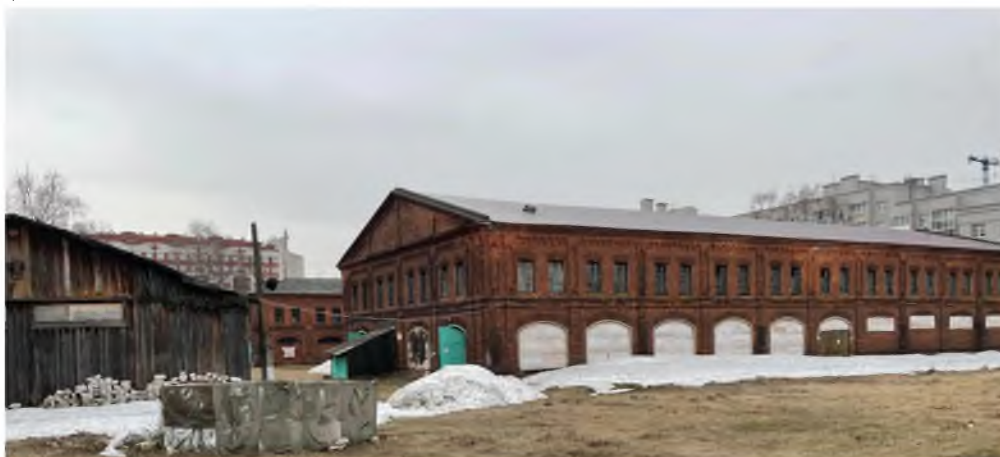
Рис. 1. Руинированный объект – Корпус мануфактурных складов Нижегородской ярмарки
