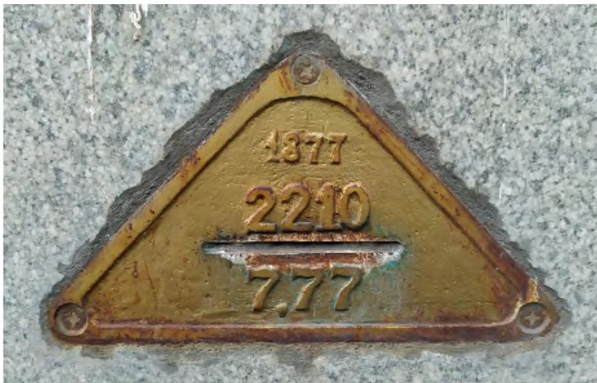
Рис. 11. Восстановленная нивелирная марка № 2210 1877 года конструкции Д. П. Рашкова в стене часовни святого благоверного князя Даниила Московского
