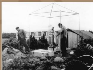
1967 г. Эстония. Работы с оборудованием для гидростатического нивелирования
